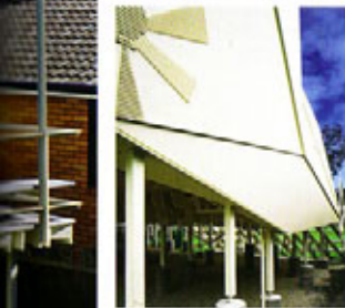
A DISTRETTO LA SCALA FORMA UNA SORTA DI ARBITRARIO VERSO IL GIARDINO. IN ALTO: UN CUCINO FORMATO DA PIANI DI DIVERSE INCLINAZIONE SA VITA AL PROSPETTO SUD. L'ESPEDIZIONE UTILIZZA SINGOLAMENTE SISTEMI PASSIVI DI RISCALDAMENTO.
